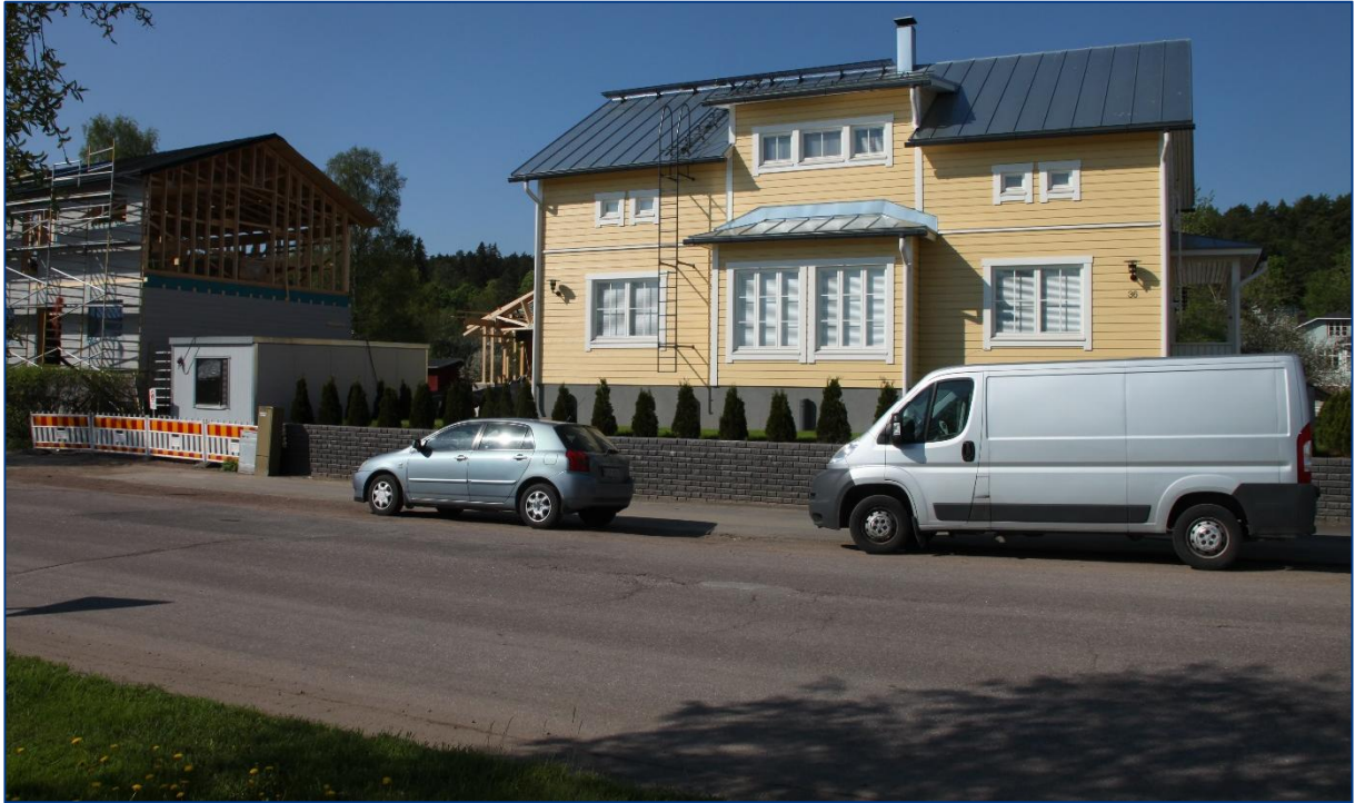
Kuva 10.1.1-1. Rantatien varrella meritulvien vaara-alueella olevia uusia sekä valmisteilla olevia asuinrakennuksia Loviisan keskustan tulvanpenkereen taustalla. Uusissa rakennuksissa on otettu huomioon alimmat suositellut rakennuskorkeudet, mikä on nähtävissä sokkeleiden korkeudessa. (Kuva: FCG Suunnittelu ja tekniikka Oy pvm. 23.5.2014)
