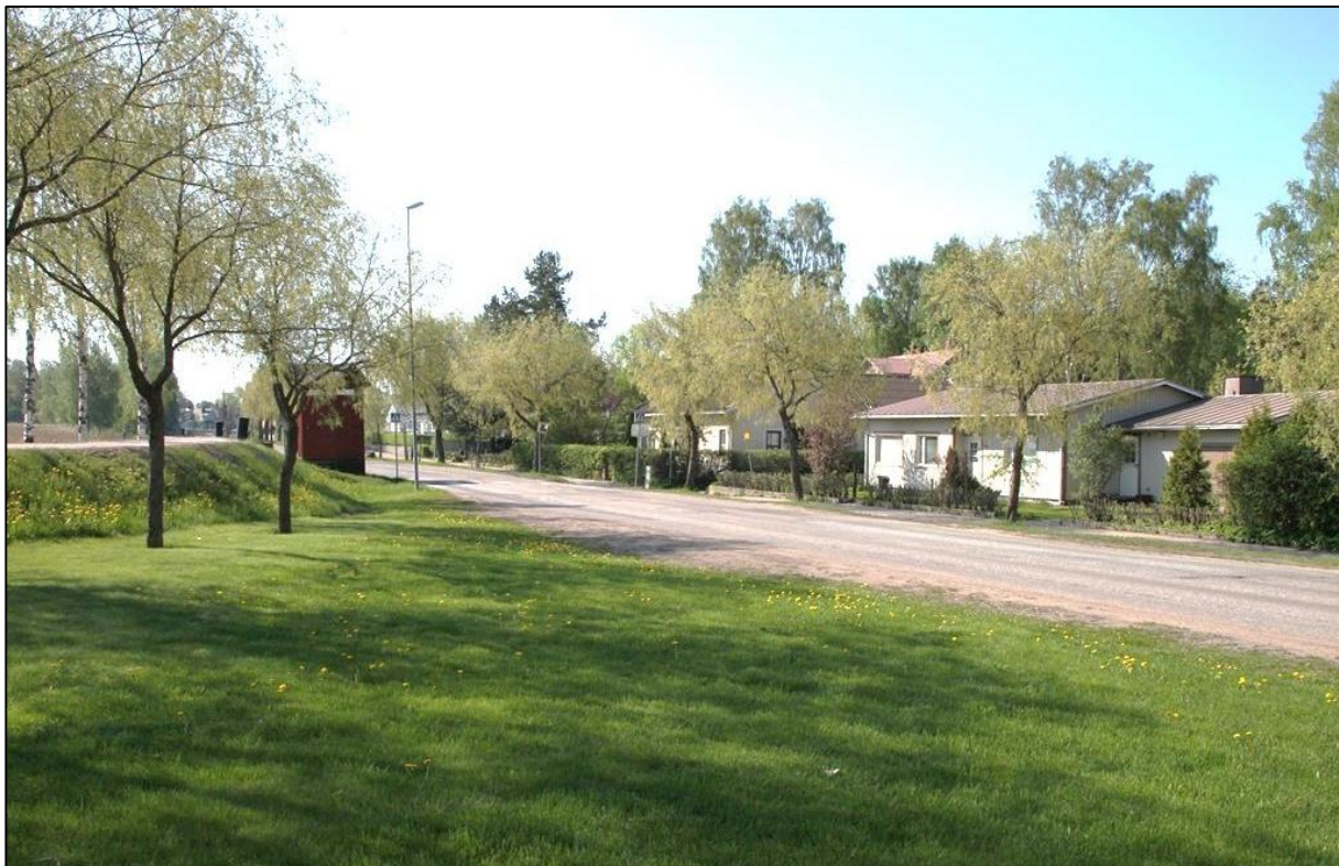
Kuva 7.2.3-2. Loviisan keskustan tulvapenger ja sen taustalla Rantatiellä olevia asuinrakennuksia. (Kuva: FCG Suunnittelu ja tekniikka Oy, pvm. 23.5.2014)
