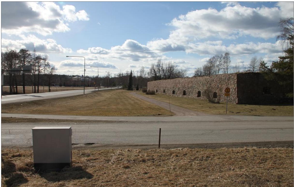
Kuva 7.4-1. Loviisan linnoituksen ulkovarustukseksi rakennettu bastioni Unger (Kuva: FCG Suunnittelu ja tekniikka Oy).
