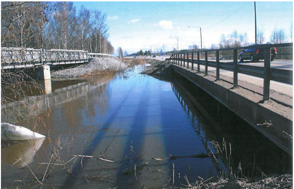
Kuva 19. Keväällä 2011 Laihianjoki nousi uomastaan tien 715 viereisiin ojiin.
