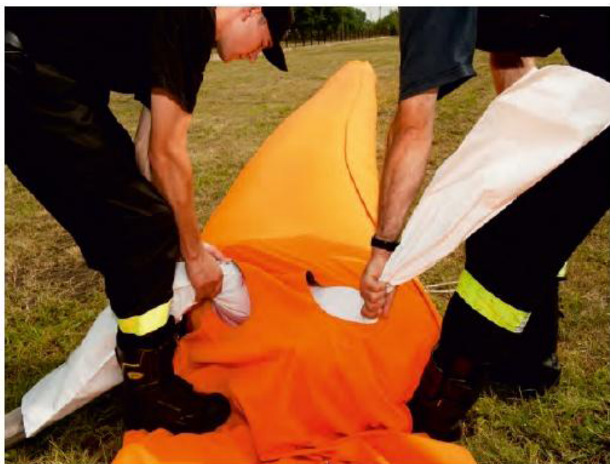
Kuva 7. Tulvasuojausesimerkki. Pelastuslaitoksen tilapäinen tulvaseinä, ns. tulvapatki, Laihian- ja Kyrönjoen välisellä bifurkaatioalueella (Vaasa).
