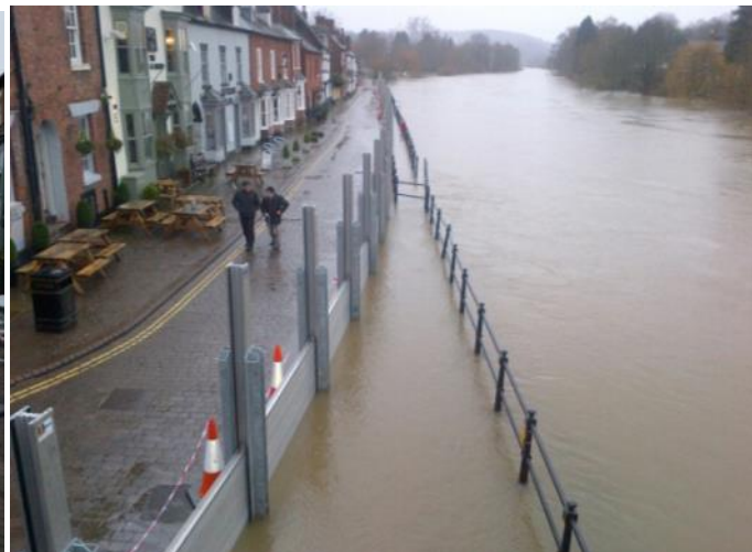
Kuva 64. Tilapäinen tulvaseinä suojaa asutusta Severn-joen tulvalta Iso-Britanniassa keväällä 2014. (©Environment Agency)
