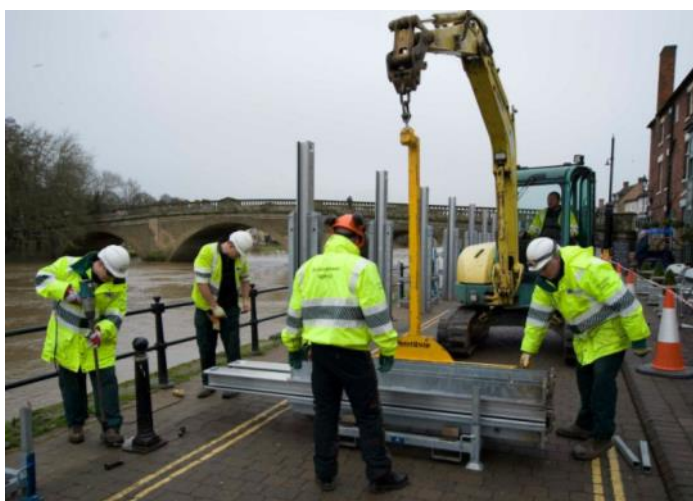
Kuva 64. Tilapäinen tulvaseinä suojaa asutusta Severn-joen tulvalta Iso-Britanniassa keväällä 2014. (©Environment Agency)
