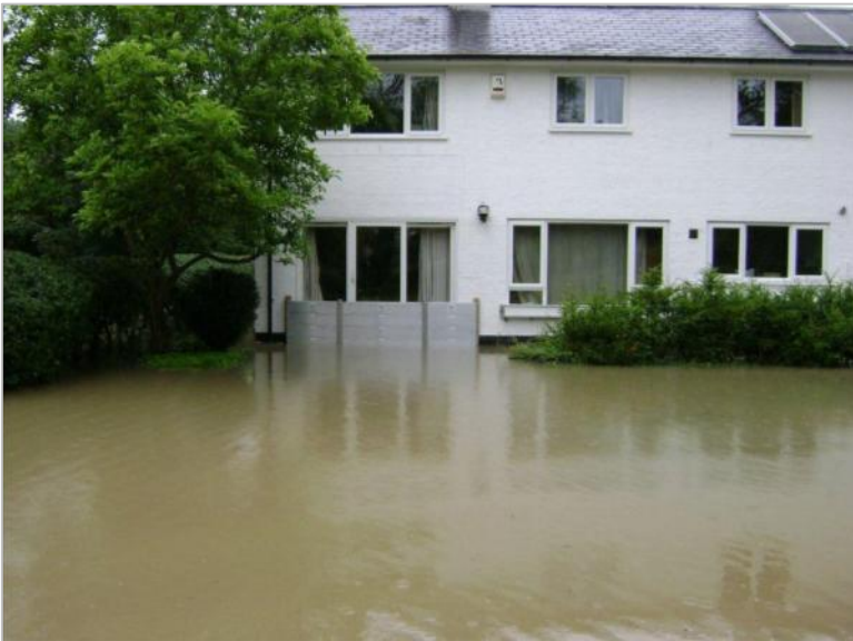
Kuva 67. Esimerkki ovien ja ikkunoiden tulvasuojauksesta Iso-Britannian talven 2013—2014 tulvassa. (©Environment Agency).
