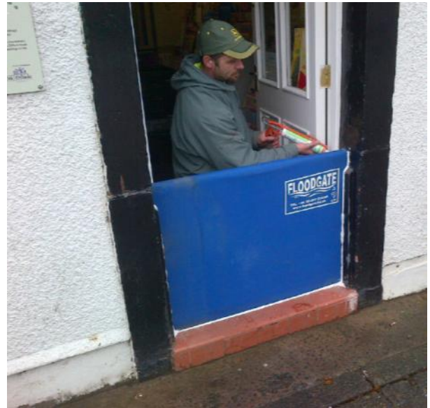
Kuva 67. Esimerkki ovien ja ikkunoiden tulvasuojauksesta Iso-Britannian talven 2013—2014 tulvassa. (©Environment Agency).
