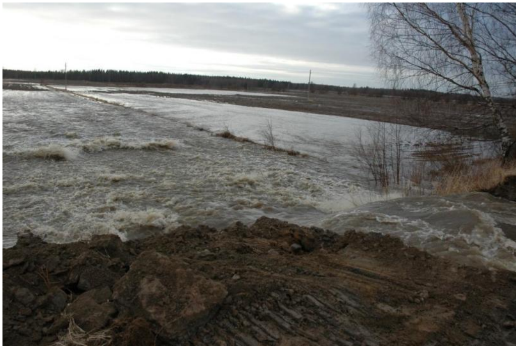
Kuva 27. Lapväärtinjoen alaosaan avattiin penger tulvavahinkojen vähentämiseksi keväällä 2013 (Kim Klemola)
