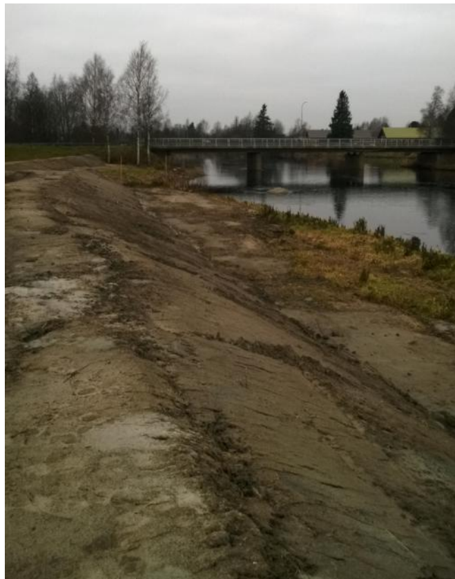
Kuva 46. Esimerkkejä ensimmäisen vaiheen aikana Lapväärttiin rakennetuista tulvapenkereistä ja –seinistä Holmforsin (vas.) ja Uudensillan (oik.) kohdilta. (Liisa Maria Rautio)
