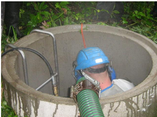
Tikkaat, kypäriä ja turvaköysi ovat ehdottomia varusteita kaivon mentäessä. Foto: Sanna Vienonen
