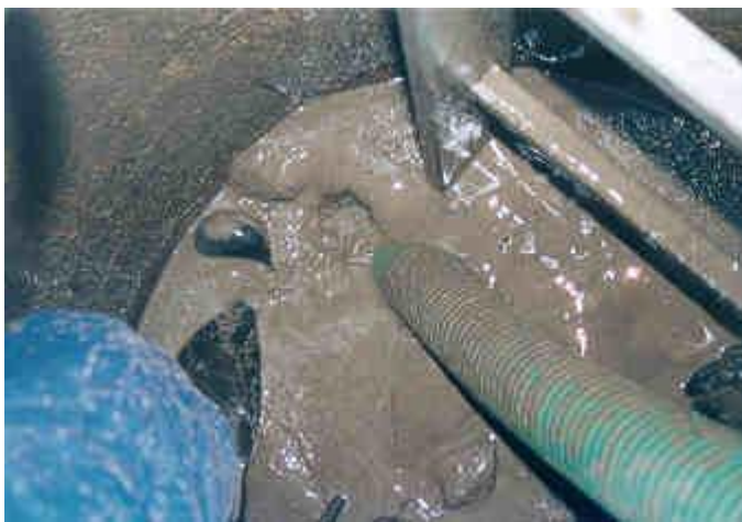
Borttagning av slam på brunnens botten. Foto: Pertti Virtanen
