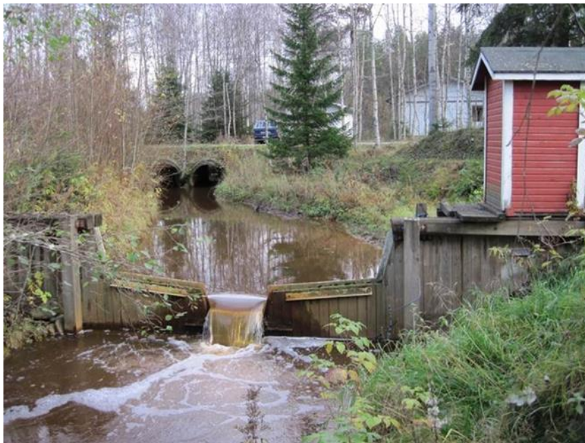
Kuva 9-1 Huopakinojan mittapato
