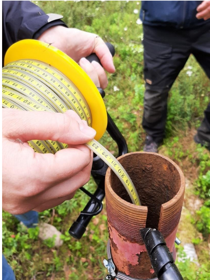
Kuva 7-3 Pohjaveden pinnakorkeuden mittaus pohjavesiputkesta
