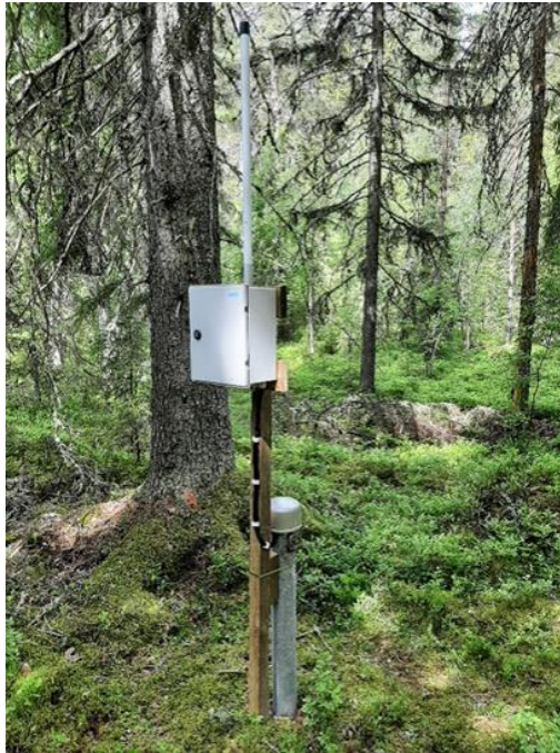
Kuva 7-1 pohjavesiputki ja siihen asennettu automaattimittauslaitteisto
