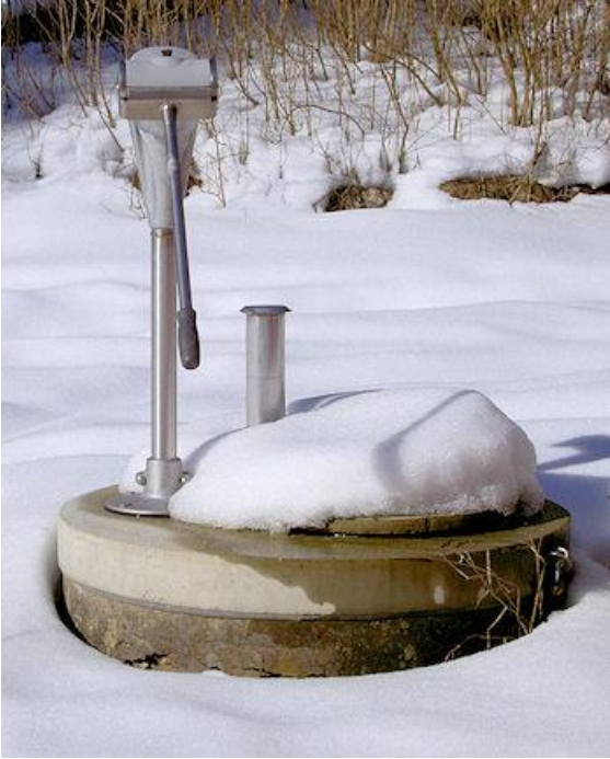
Kaivon kannella sulava lumi voi heikentää vedenlaatua kaivossa, jos rakenteet eivät ole kunnossa. © Toivo Lapinlampi
