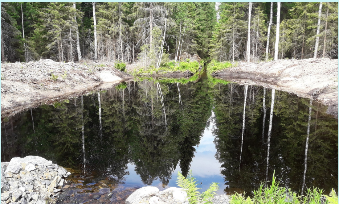
Kuva 24 Laskeutusallas Lohiluomaan laskevan Huhtaluoman suulla kesällä 2017 (yllä) ja eroosiosuojauksen toteuttamisen jälkeen kesällä 2019 (alla)
