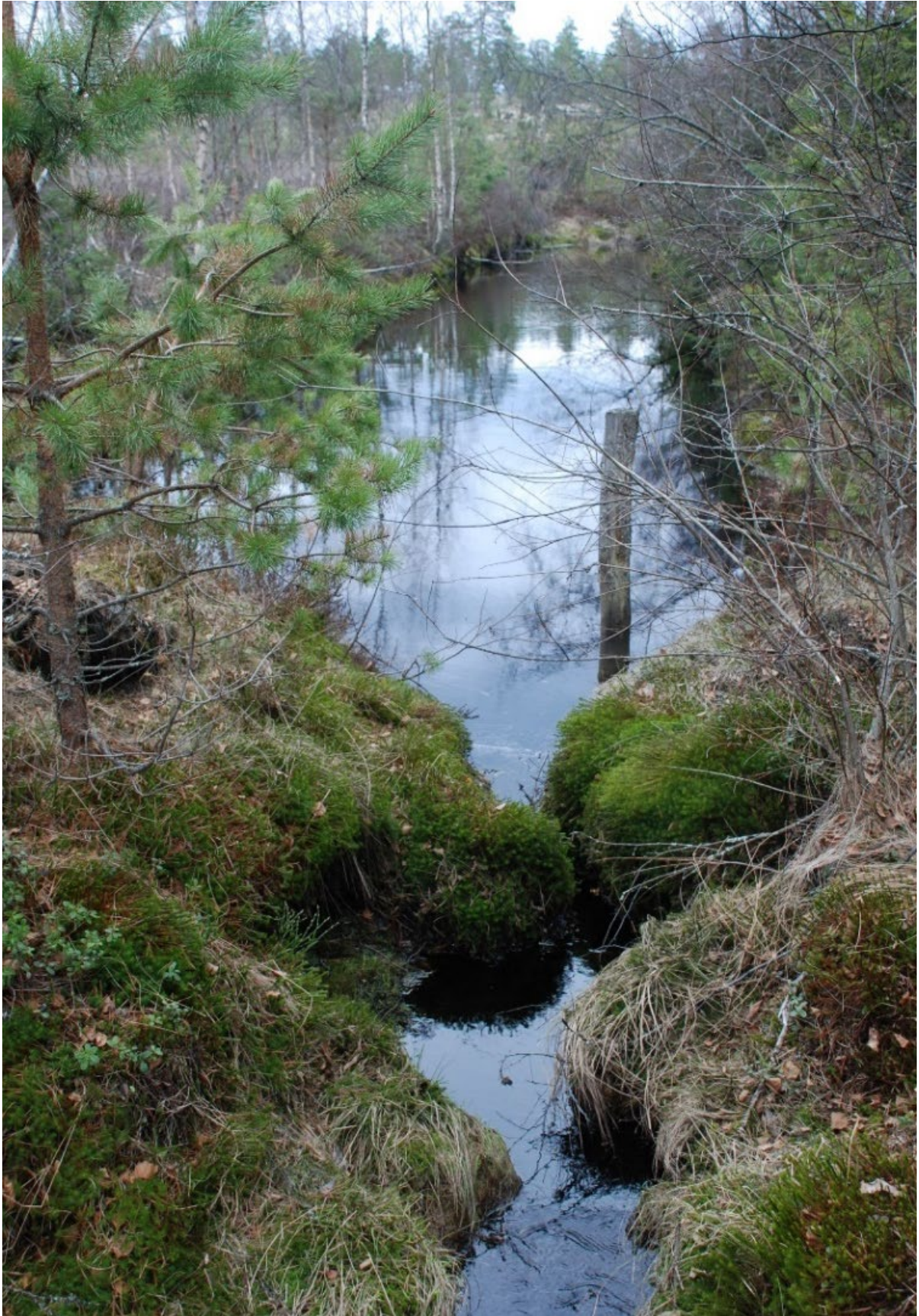
Kuva 22 Laskeutusaltaat voivat pidättää karkeaa ja keskikarkeaa kiintoainetta, mutta liukosiin ravinteisiin ja orgaaniseen hiileen niillä ei ole vaikutusta. Kuva: Samuli Joensuu
