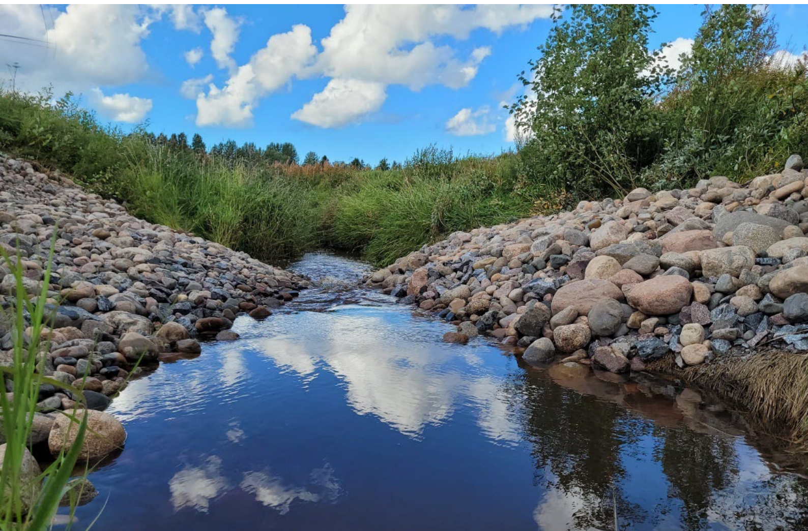
Kuva 23 Pohjapadot hidastavat veden virtausta ja voivat vähentää uomaeroosiota. Kuva: Juho Holappa
