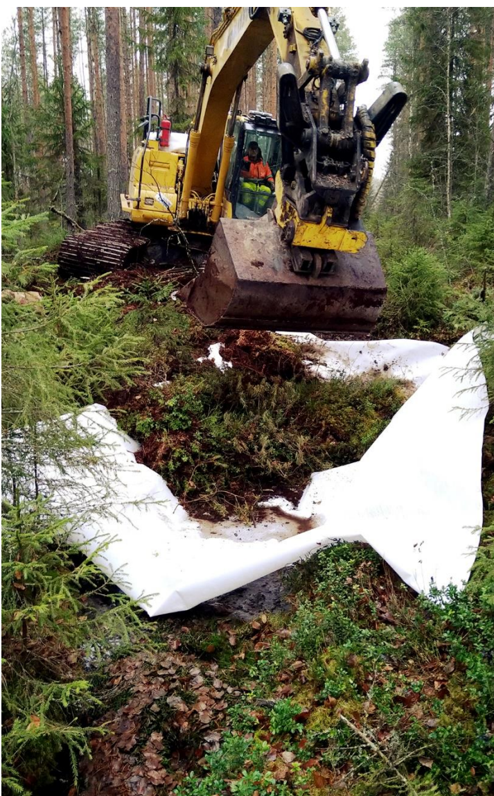
Kuva 101. Asko Yli-Kauppila vahvistaa vedenohjaukseen tarkoitettua patoa suodatinkankaalla. Järeät padot syntyvät kaivinkonetyönä.
