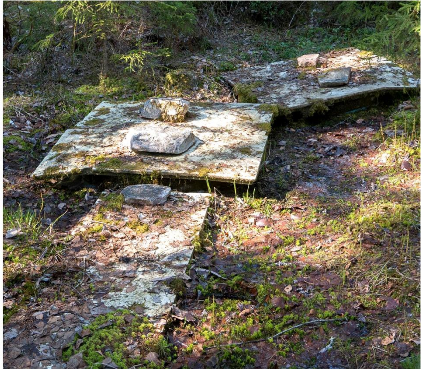
Kuva 75. Lähteiköllä on kaksi pohjaveden purkauspistettä, joista molemmat on valjastettu betonirenkailla. Kaivot on peitetty styroksilevyillä ja kivillä. Molempien lähdekaivojen ylivuoto on ohjattu kuvan etualalla näkyvään kaivettuun uomaan, joka sekkin on peitetty styroksilla. Lähteisyys rajautuu betonirenkaiden ja peitetyn uoman sisään. Lähteikkö on rakennepiirteiltään ja vesitaloudeltaan erittäin muuttunut ja kohteella on ennallistamistarve.
