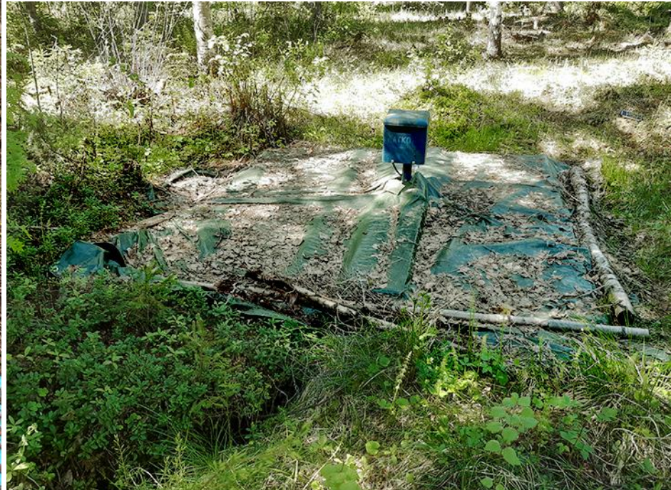
Kuva 93. Allikkolähde on kaivettu neliskanttiseksi altaaksi ja lasku-uoma on perattu suoraksi ojaksi. Allikko on peitetty järeillä tukeilla, pressulla ja pressua paikallaan pitävillä puurimoilla. Lähteessä on vedenottopumppu ja vesi on johdettu putkella suoraan kiinteistön käyttövedeksi. Mikäli vedenottotarve joskus päättyy, lähde voidaan ennallistaa suurimmat ja peittävimmat vedenottorakenteet raivaamalla ja lasku-uomaa monimuotoistamalla.
