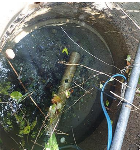
Kuva 68. Lähdekaivoon kurkistaminen on tärkeää. Kuvan betonirenkaan sisään purkautuu silminnähdessä pohjavettä ja renkaassa on ylivuotoputki. Vesi on voitu johtaa putkella joko lähiympäristöön tai suoraan kiinteistön käyttövedeksi. Lähdekaivoon sisästä purkautuva pohjavesi voi valua ylivuotona myös betonirenkaiden alta tai väleistä.
