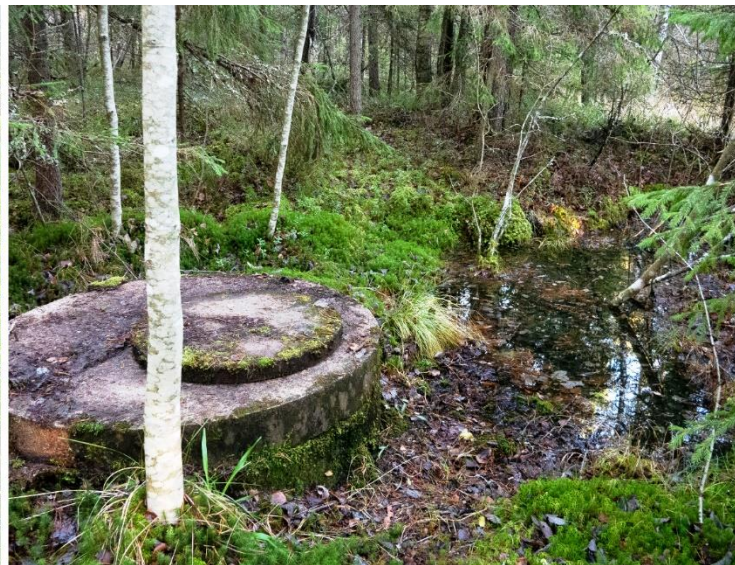
Kuva 73. Lähdekaivosta syntyy lähdeveden ylivuotoa, joka tihkuu hitaasti betonirenkaiden välistä ja suotautuu allikon ja kaivon välissä olevan maavallin läpi. Kaivo peittää lähes puolet allikon pinta-alasta ja rakenteet ovat hidastaneet veden virtausta purkauspaikasta niin paljon, että allikko on seisovavetinen (vertaa kuva 76). Lähteellä on ennallistamistarve.
