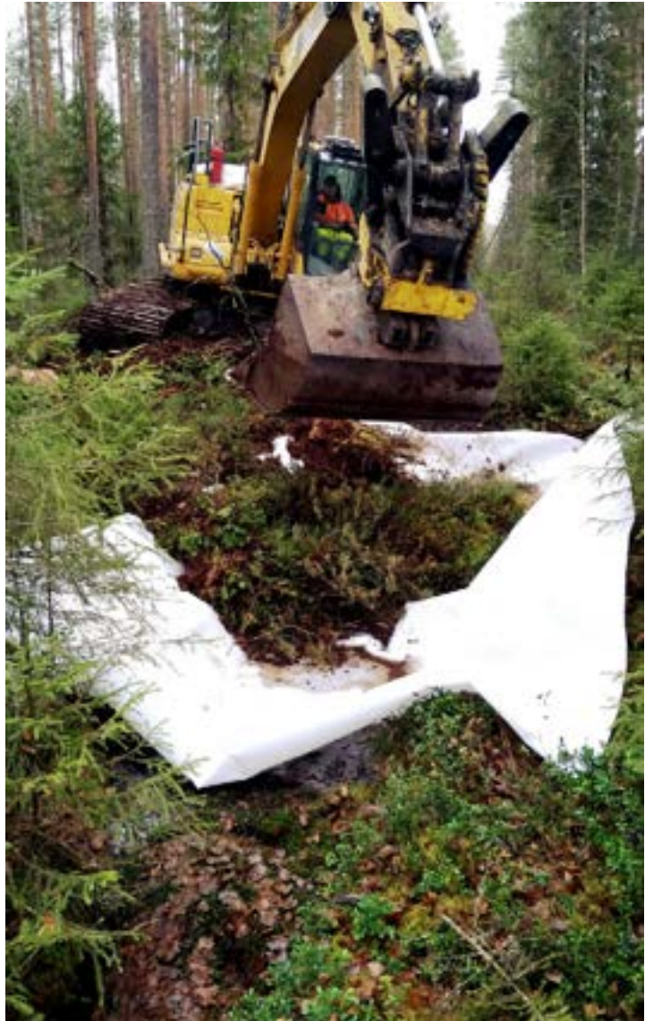
Kuva 101. Asko Yli-Kauppila vahvistaa vedenohjaukseen tarkoitettua patoa suodatinkankaalla. Järeät padot syntyvät kaivinkone työnä.
