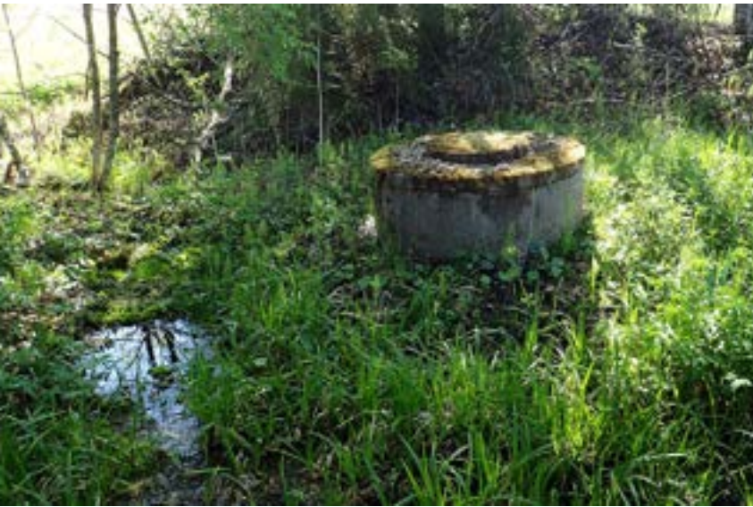
Kuva 72. Lähdekaivoa ympäröi hetteinen lähteikkö. Betonirenkaan sisälle purkautuu pohjavettä, mutta aivan kaivon välittömässä läheisyydessä ei ilmene lähteisyyttä. Syy piilee kaivon ympärille kasatussa ja tiivistetyssä maavallissa. Maavalli ja kaivorakenteet ovat muuttaneet lähteikön rakennepiirteitä ja vesitaloutta, minkä seurauksena lähteinen pinta-ala on supistunut. Lähteiköllä on ennallistamistarve.
