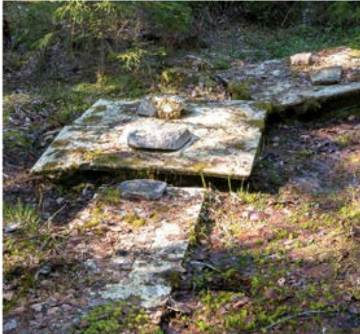
Kuva 75. Lähteiköllä on kaksi pohjaveden purkauspistettä, joista molemmat on valjastettu betonirenkailla. Kaivot on peitetty styroksilevyillä ja kivillä. Molempien lähdekaivojen ylivuoto on ohjattu kuvan etualalla näkyvään kaivettuun uomaan, joka sekkin on peitetty styroksilla. Lähteisyys rajautuu betonirenkaiden ja peitetyn uoman sisään. Lähteikkö on rakennepiirteiltään ja vesitaloudeltaan erittäin muuttunut ja kohteella on ennallistamistarve.
