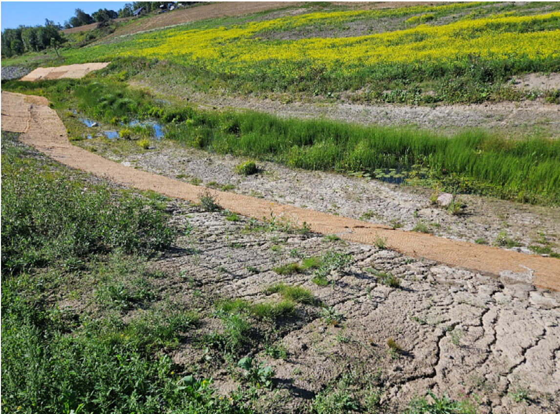
Bild 3. Det lönar sig att skydda en erosionskänslig slänt med till exempel geotextil (på bilden kokosmatta) som är kombinerad med en färdig fröbank för att påskynda groningen på slänten. Mattan fästs på slänten med hjälp av trätappar som placeras tillräckligt tätt.
