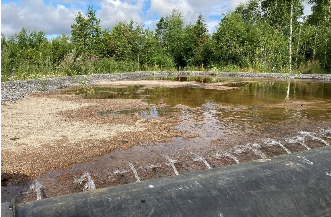
Kuva 6. Kymijärven hiekkasuodatuskenttä, johon ilmastettu alusvesi tulee pitkällä jakoputkella. Kuva: Leena Nurminen.
